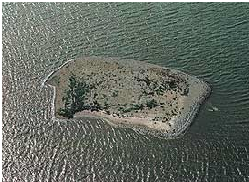
Figuur 3.1.1 De Visdief (Eemmeer), kale zandplaat met grindverdediging. Bron: RWS IJsselmeergebied
