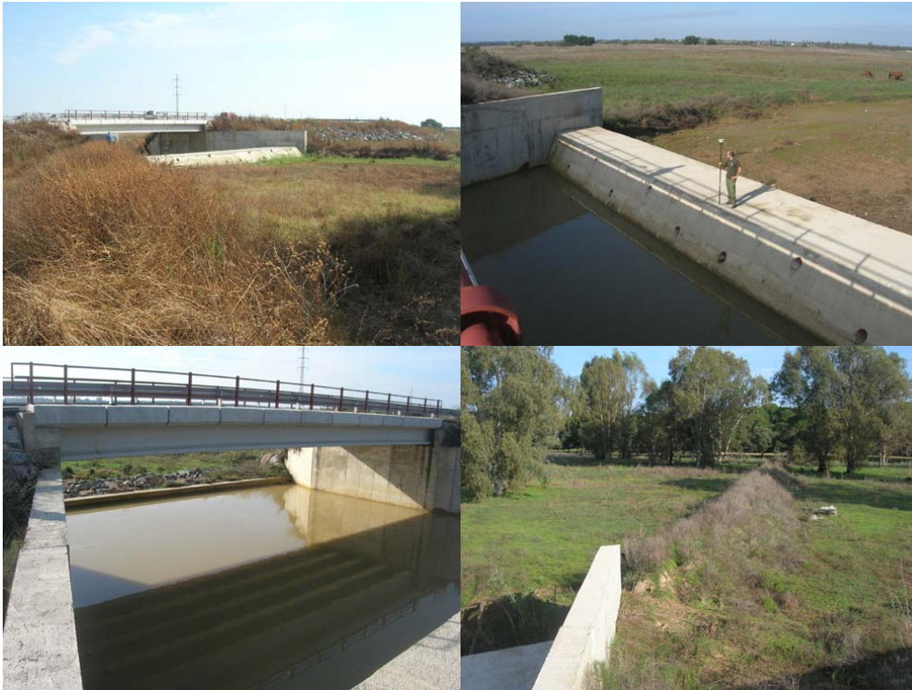
Figura 9. Fotografías superiores: Vistas del dique construido en el arroyo de la Cañada del Pinar, inmediatamente aguas arriba del puente sobre el mismo del camino asfaltado entre El Rocío y Villamanrique. Fotografías inferiores: A la izquierda detalle de los muros laterales de hormigón que conforman el vertedero del dique. A la derecha la prolongación del muro de hormigón del vertedero por otro de tierra, para encauzar la corriente hacia el vertedero. Este muro de tierra evita que el agua pueda desviarse al paso de fauna situado por debajo de la carretera, a la izquierda de la obra.
