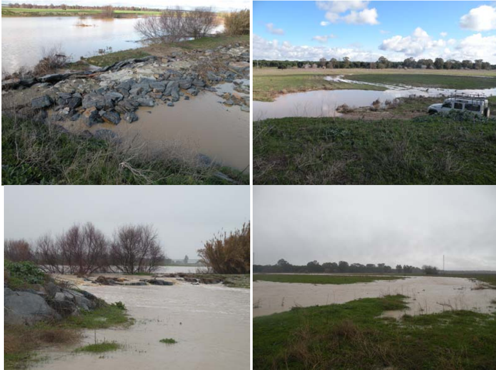
Figura 19. Fotografías superiores. Estado de la avenida del arroyo del Partido en el vertedero lateral del DIQUE 1 y en el área de inundación-laminación establecida en la Actuación núm. 3 a las 13:40 horas locales del día 2-02-2009. Izquierda: vertedero lateral del DIQUE 1. Se observa que ha dejado de pasar agua por encima de él a esa hora. Derecha: Superficie inundada con anterioridad, tras el paso de la avenida por el vertedero lateral, en el área destinada a tal fin con la Actuación núm. 3 . Fotografías inferiores. Estado de la avenida del arroyo del Partido en el vertedero lateral del DIQUE 1 y en el área de inundación-laminación establecida en la Actuación núm. 3 a las 13:20 horas locales del día 5-02-2009. Izquierda: paso de la avenida por los 60 m operativos del vertedero lateral del DIQUE 1 hacia el área de inundación-laminación. Derecha: inundación en el área reservada al efecto y su adecuación a la topografía definida por los antiguos derramaderos existentes en el lugar. (Fotografías C. Urdiales).
