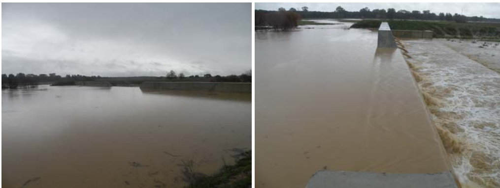
Figura 17. Estado de la avenida del arroyo del Partido en el DIQUE 1 a las 13:10 horas locales del día 5-02-2009. Atendiendo al crecimiento del hidrograma de la avenida de la Figura 16, la descarga en el arroyo del Partido en ese momento podía estar en torno a los 65 \text{ m}^3 \cdot \text{s}^{-1} . La fotografía de la izquierda muestra una panorámica del sistema de reparto de los caudales del arroyo del Partido entre los vertederos frontal y lateral del DIQUE 1. La fotografía de la derecha es un detalle de la anterior, acentuando el paso de la corriente por el vertedero frontal, por el que se estima que están descargando en el momento de la fotografía unos 20 \text{ m}^3 \cdot \text{s}^{-1} ( 15 \text{ m}^3 \cdot \text{s}^{-1} que pasan por los mechinales y el resto por el umbral del vertedero). Fotografías C. Urdiales.
