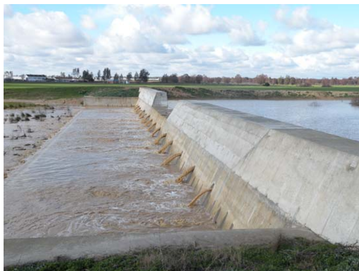
Figura 13. DIQUE 1 tras la rectificación del perfil de su vertedero frontal, operativo en enero de 2009, a las 13:00 horas locales del día 2-02-2009, tras la avenida iniciada en la tarde-noche anterior (imagen cedida por C. Urdiales, PND).
