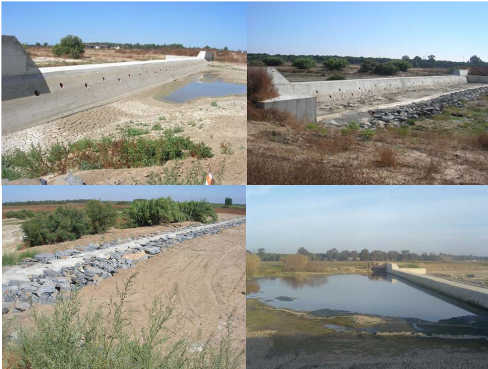
Figura 2. DIQUE 1 construido en el arroyo del Partido al inicio de su antiguo cono de sedimentación, que constituye el elemento director del esquema restaurador del arroyo adoptado en la Actuación núm. 3 del Proyecto Doñana 2005 . Fotografías superiores: vertedero frontal, con el perfil original de 2006, visto desde aguas arriba (izquierda) y desde aguas abajo (derecha). Fotografías inferiores: Vertedero lateral del dique, detalle (izquierda) y panorámica desde aguas arriba (al fondo de la imagen derecha)
