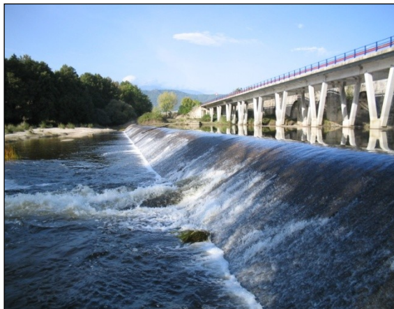
Vista del azud en aguas altas
