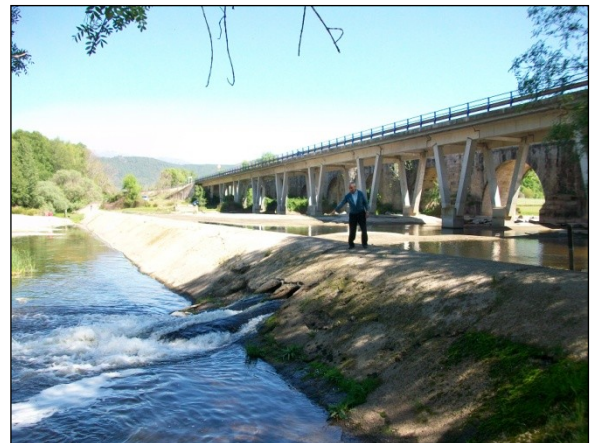
Vista del azud en aguas bajas
